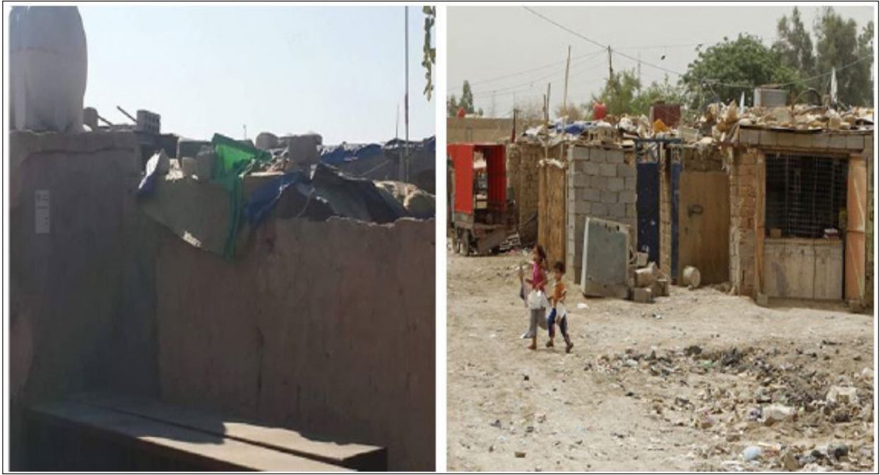
صورة (١) المواد المستخدمة في البناء.
